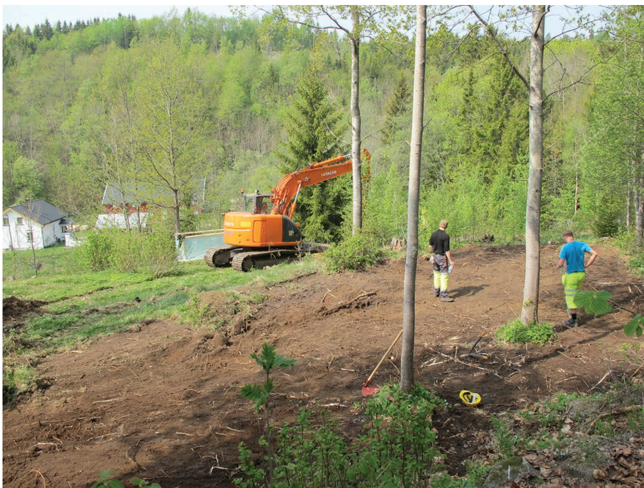
Figur 14.1.3. Avtorving på Gunnarsrød 3 før graving av prøvekvadranter, sett mot nordvest. Gravemaskinen står på det laveste platået på boplassflaten.
