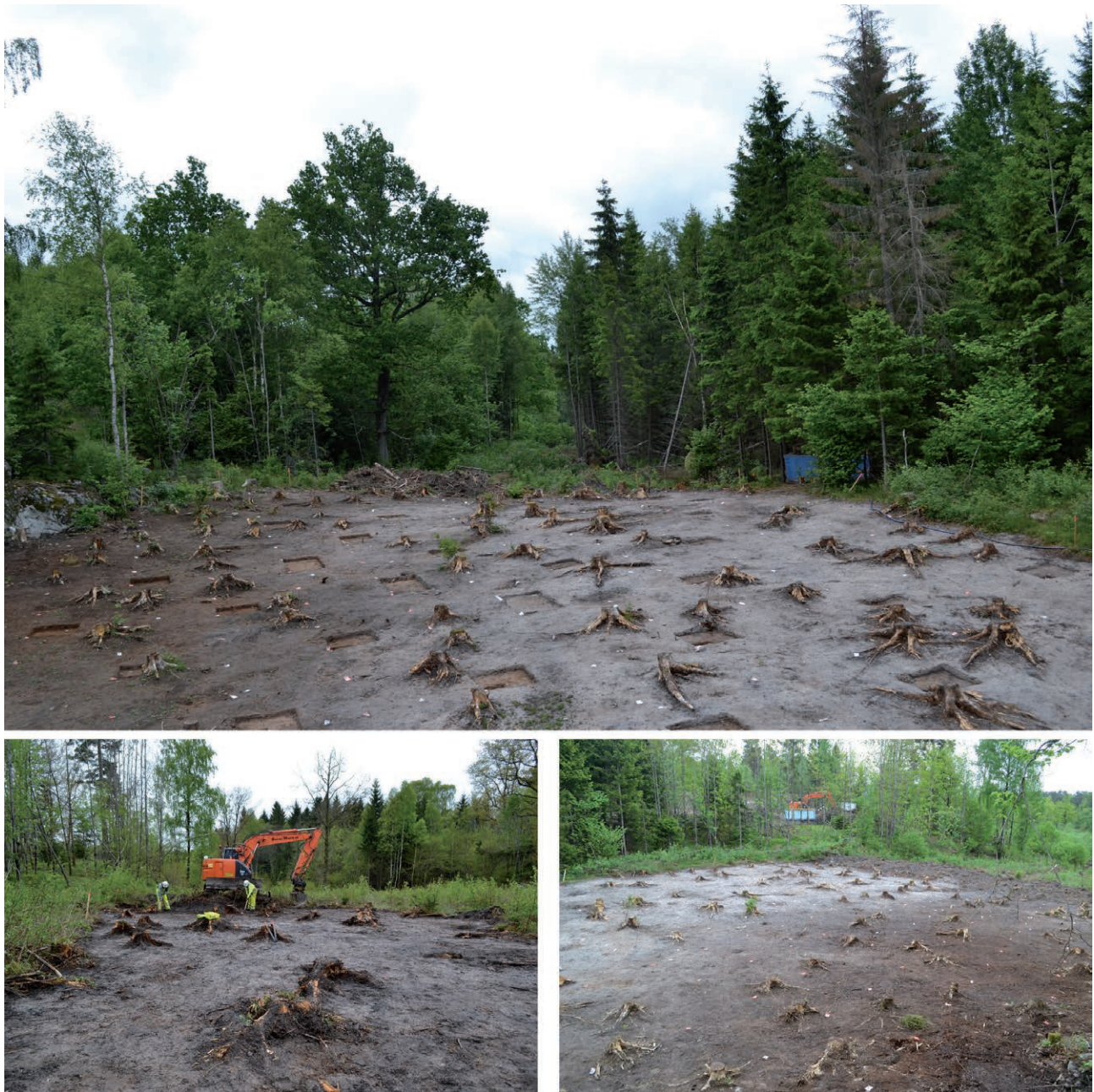
Figur 21.5. Oversikt over Hegna vest 1. Øverst: lokaliteten sett mot nord under den innledende undersøkelsen. Nede til venstre blir lokaliteten avtorvet, og nede til høyre sees flaten etter avtorving.
